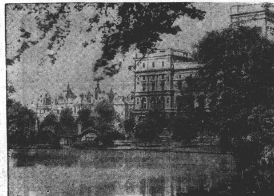
Forreign Office, angleško zunanje ministrstvo. Pogled na poslopje iz St. Jameškega parka.
