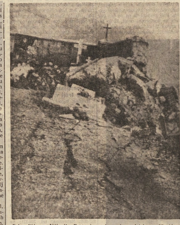
Pokopališče v Viškorši. Potresni sunki so razdelali, porušili zidove. Zemlja se je dejansko odprla. Sunki so podrla nagrobne kamne.
