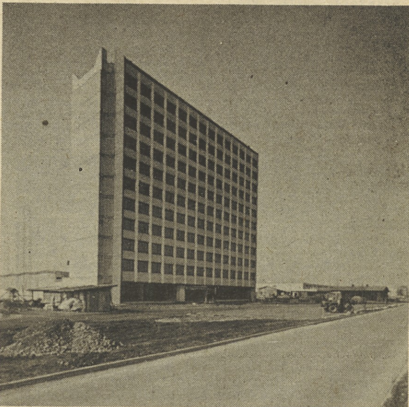
Na posnetku je nova zgradba Centra sistemov za avtomatizacijo na s. renskem industrijskem kompleksu Iskre, katere gradnja prehaja v zaključno fazo. O centru sistemov za avtomatizacijo podrobneje na 3. strani.
