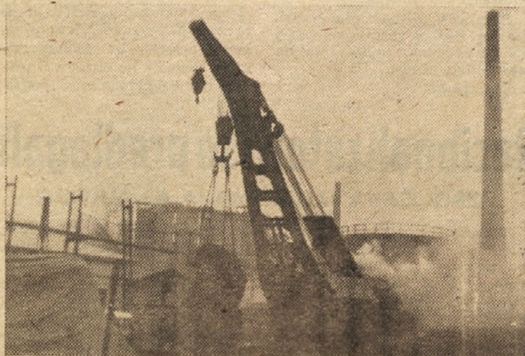
Na pomoč je prišel železniški žerjav, ki nam je pomagal razklati pogonske motorje za našo centralo
