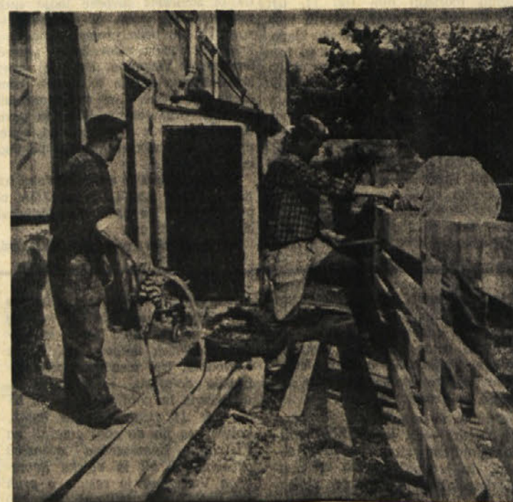
Na vrtu hišne šte. 93 v Ul. Valerio postavljajo delavci podjetja Cumini leseno ograjo, ker se ruši zemlja
