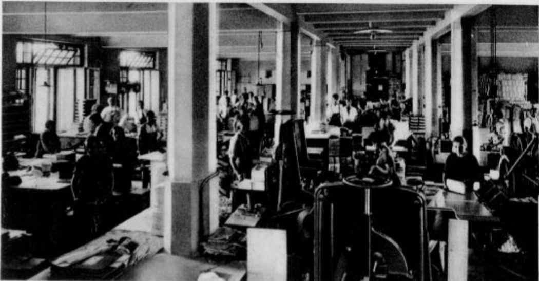
Knjigoveznica, najmoderneje opremljena, zaposluje 60 delavcev.
