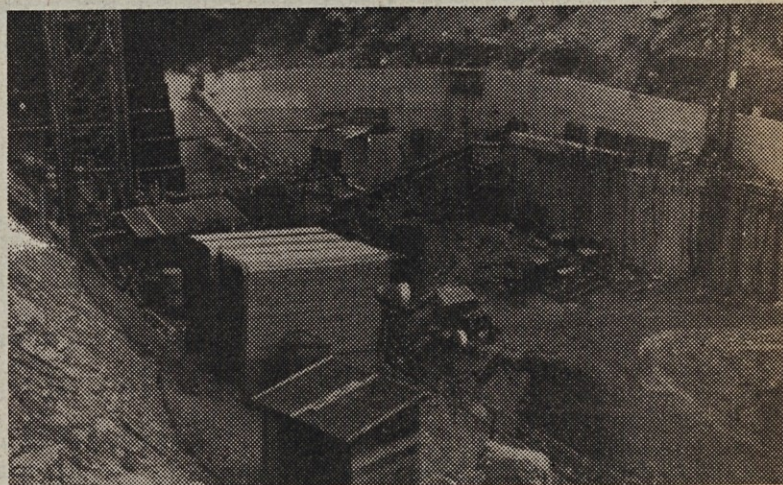
Izredno zahtevno je gradbišče za HE Solkan in temu primerna mora biti tudi mehanizacija
