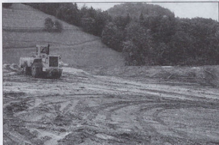
Urejanje vrhnjega dela odlagališča, kjer bo po končanih delih prostora za več kot nogometno igrišče.
