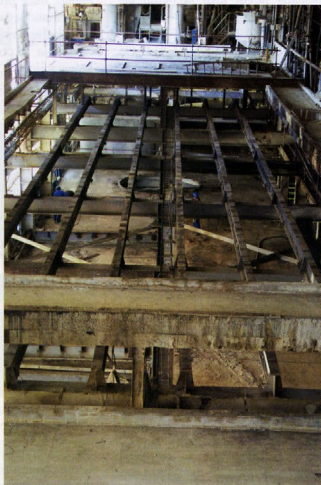
Po odstranitvi bazenov in kadi je v vseh etažah zazevala praznina - lokacija (+ 12 metrov), kjer bosta postavljeni vertikalni membranski filter stiskalnici.
