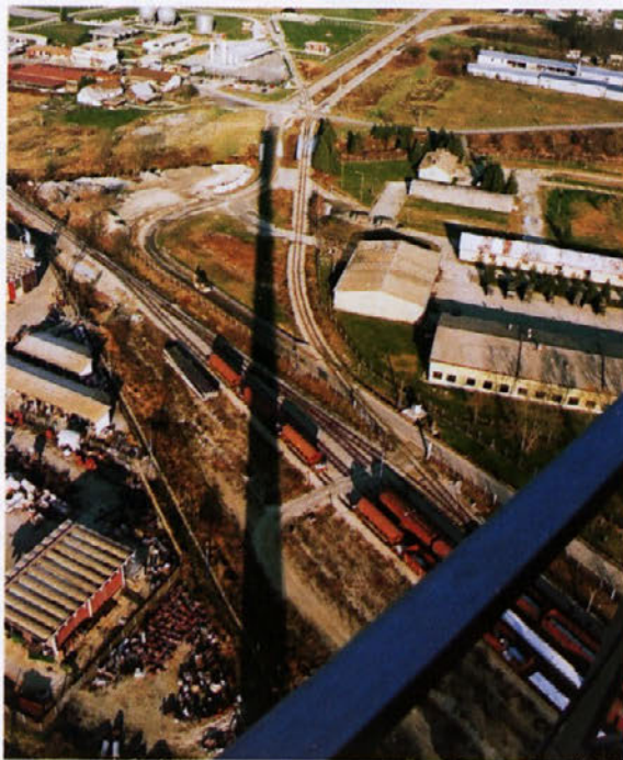
Pogled na senco s 100 m visokega dimnika
