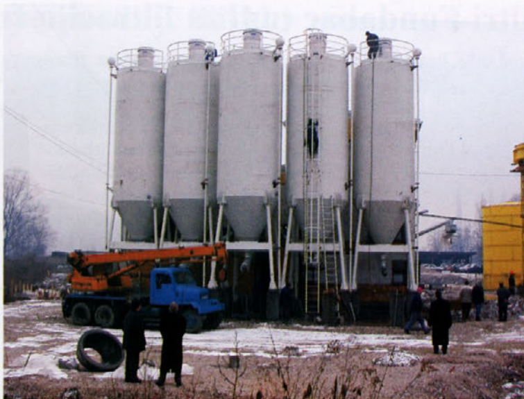
Delavci Libele Elsi nameščajo silose nemoteno tudi pri - 25 stopinjah Celja.
