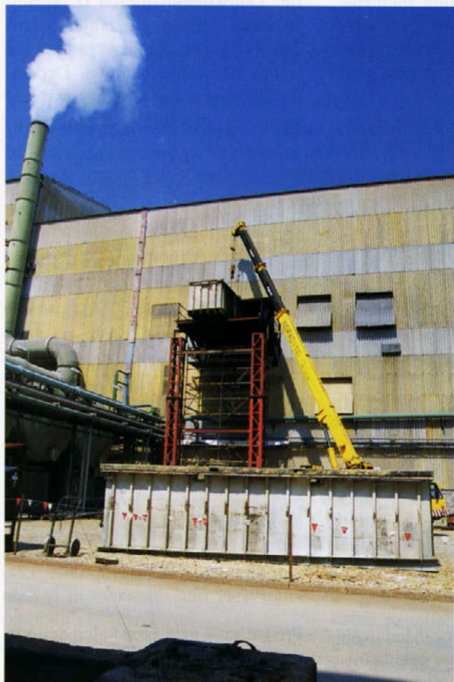
Bazene je Inometal odstranjeval preko posebej zgrajenega podesta kar v celem stanju. Odstranjevanje gume in razrez bazenov bodo, zaradi hitrejšega poteka del in preprečevanja negativnih vplivov na delovno okolje, izvajali v prihodnjih mesecih na dvorišču.
