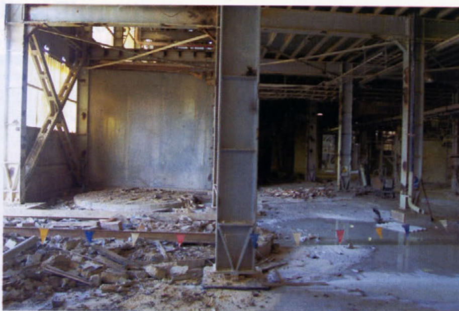
Rušenje tlakov na etaži 0 metrov.
