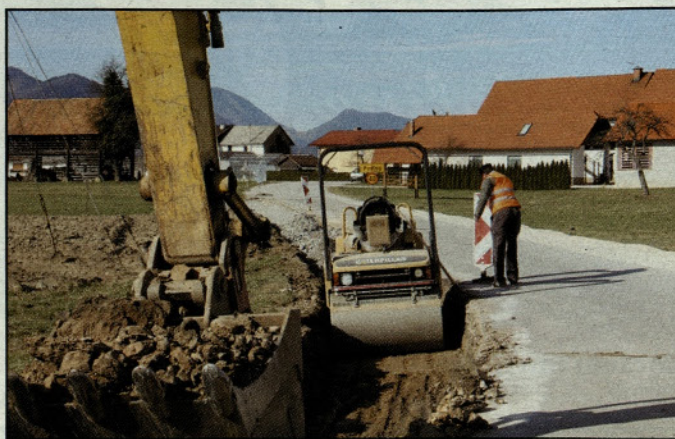
Obnova ceste Gotovlje-Podlog
