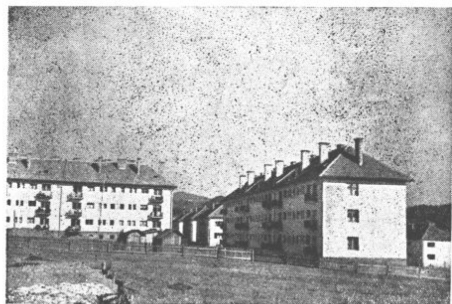
Rudniška kolonija v izgradnji
