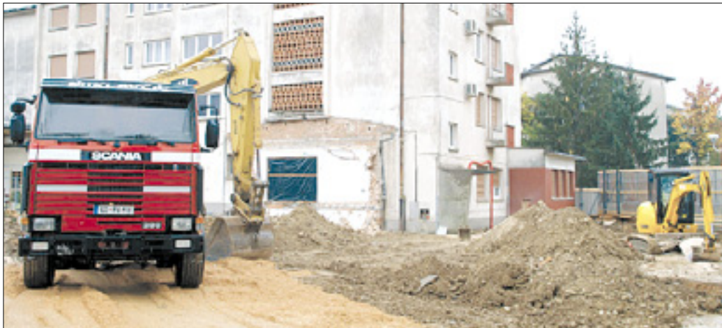
Gradbišče ob glasbeni šoli
