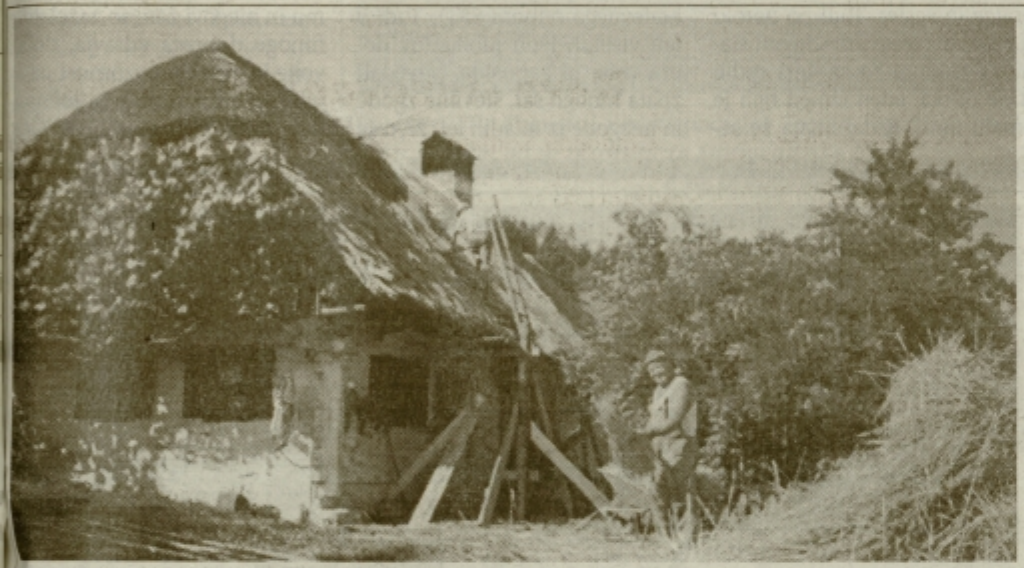
Jaka in Ludvik sta se prekrivanja strehe pogumno lotila kar sama. Mojster je splezal na streho, njegov pomočnik pa se je raje zadrževal malo bolj na varnem, ob lestvi.
