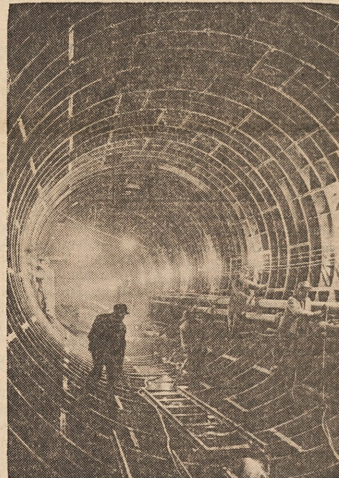
V PODZEMLJU BUDIMPEŠTE — Slika kaže gradnjo podzemnega predora v glavnem mestu Madžarske. Po njem bo tekla podzemna železnica.
