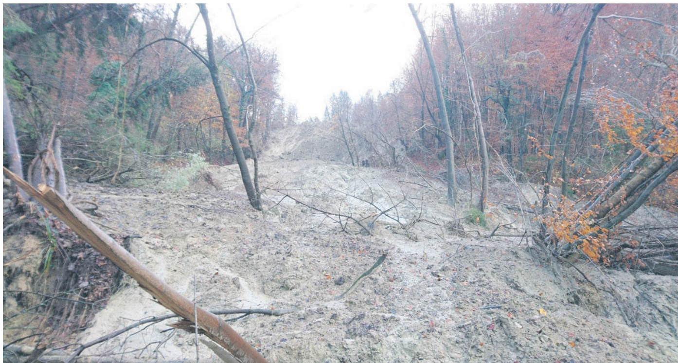
Srhljiv pogled na plaz, ki se je nad naseljem Stopce v laški občini sprožil novembra 2019. Letos se je začela njegova sanacija. Ta bo zahtevna in draga. (Foto: Občina Laško)
