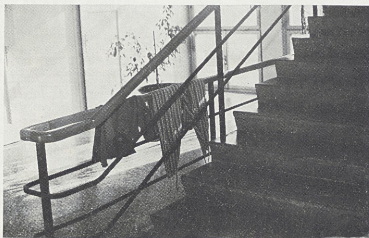
Le komu se je zgodila nesreča, da je moral v I. nadstropju upravne zgradbe sušiti perilo?!
