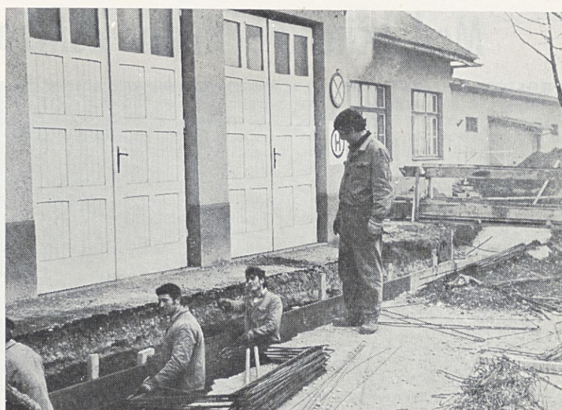
Skoraj redno so parovođe v letno kopališče in kopalnice popravljali takrat, ko se je sezona že začela. Letošnja zima je ta popravila dopuščala pravočasno. Na sliki je gradnja parovodnega jaška pred gasilskim domom. (Foto: Ciril Zupančič)
