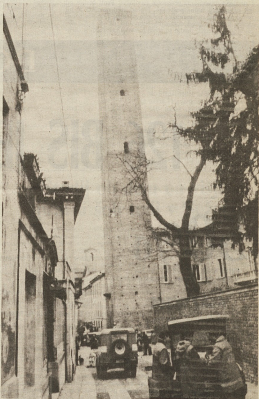
Izvedenci so senzorce za odkrivanje sprememb v zidovju namestili tudi v stolp Belcredi (Telefoto AP)
