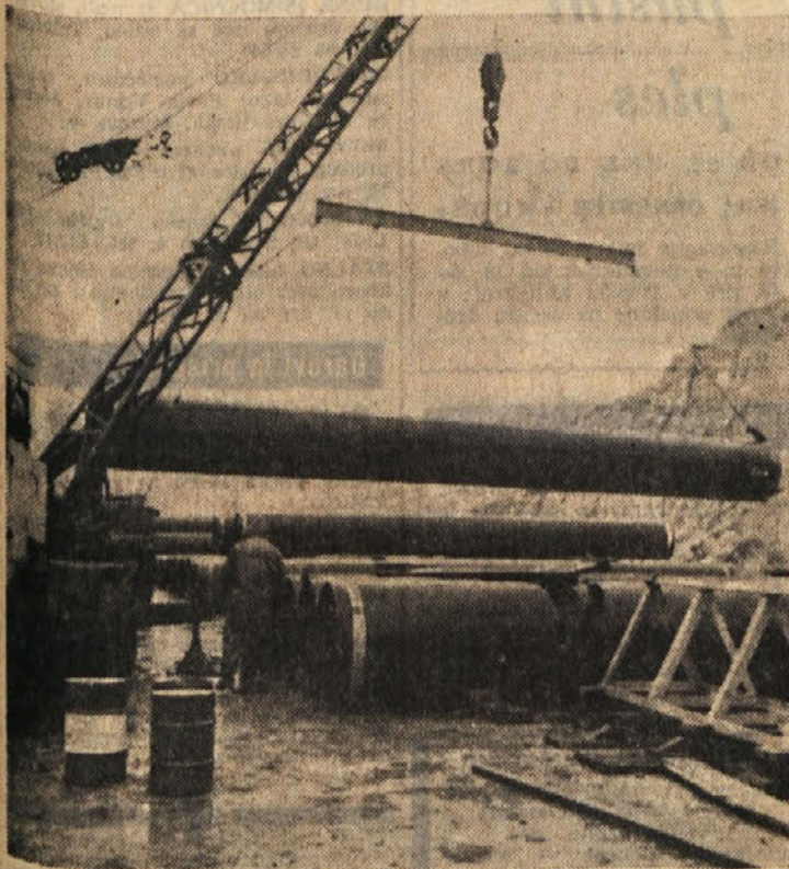
Pri Trzinu raztovarjajo cevi za naftovod
