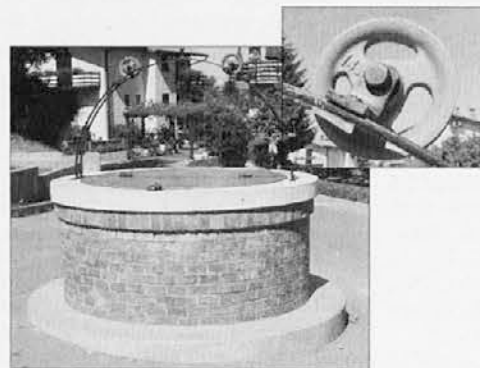
Obnovljen vodnjak v Zapučkah v Vrtojbi
