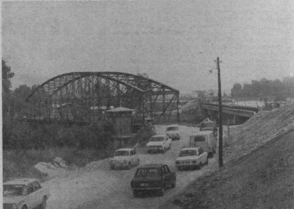
Promet po novem mostu čez Savo pri Šentjakobu bo tekel po dveh vozniških pasovih. Vozišče bo široko 8 metrov s pločnikoma ob robu, širokima po meter in pol. Železni stavec mora vzdržati do otvoritve betonskega lepota.
