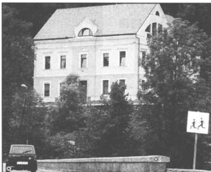
Podružnično šolo so le delno obnovili. V prihodnje bodo poskušali zgraditi še večnamensko telovadnico, kot to predvidevajo izdelani idejni projekti, in poskrbeti za večjo varnost pešcev.
