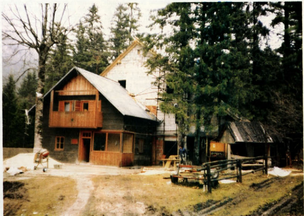
Počitniški dom Cinkarne v Logarski dolini v času gradnje. Fotografija prikazuje še stari dom, ki je že porušen, na tem mestu pa stoji nov (prikazuje ga fotografija na 2. strani). Zidovi zidanega dela doma so ostali isti, le da so tudi ti obnovljeni.
