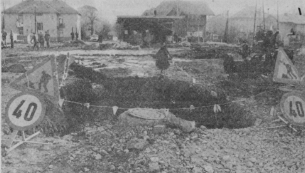
Pri podvozu na Kersnikovi ulici morajo gradbinci najprej prestaviti komunalne vode, podvoz pa naj bi bil zgrajen že do prihodnjega poletja.
