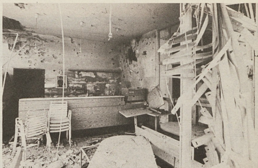
Notranjost razdejanega bifeja pri bencinski črpalki
