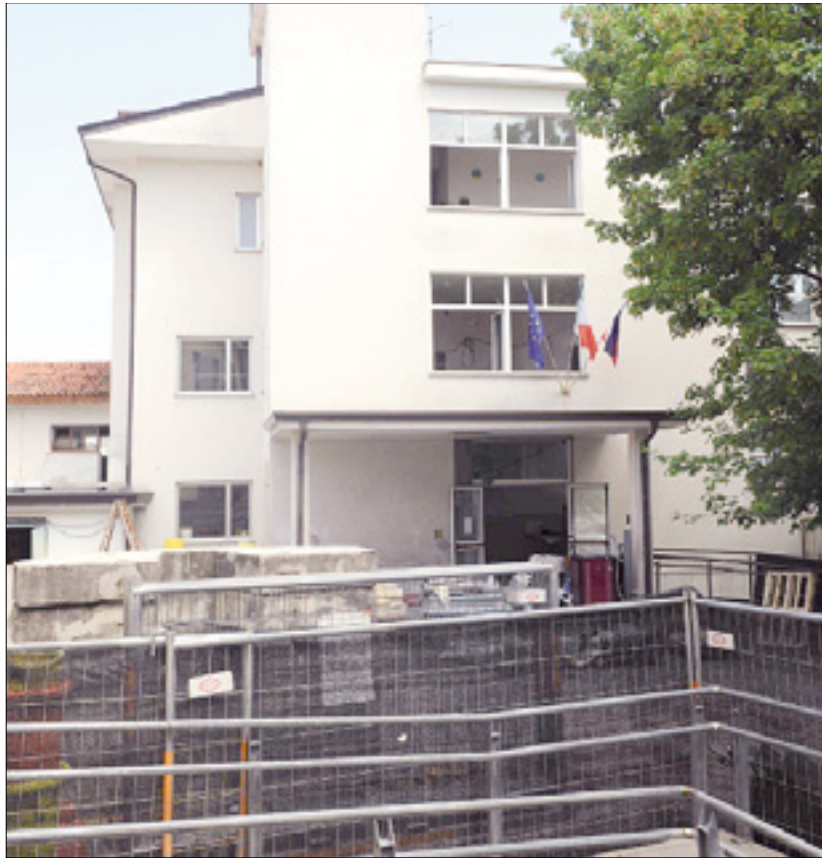
Gradbišče pred šolsko stavbo
