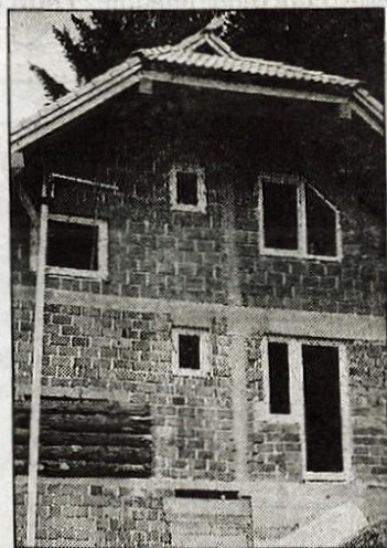
Svetinova hiša je pod streho.
