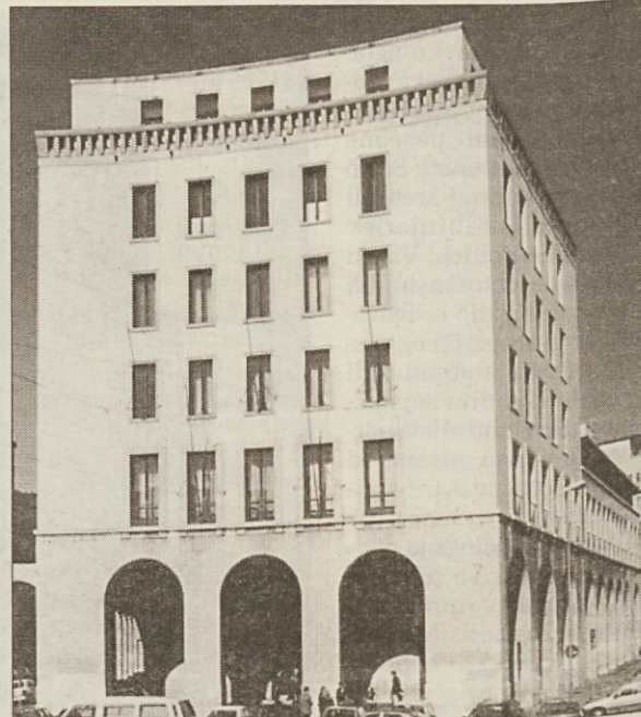
Sedež deželnega sveta, ki ga bomo 14. junija obnovili
