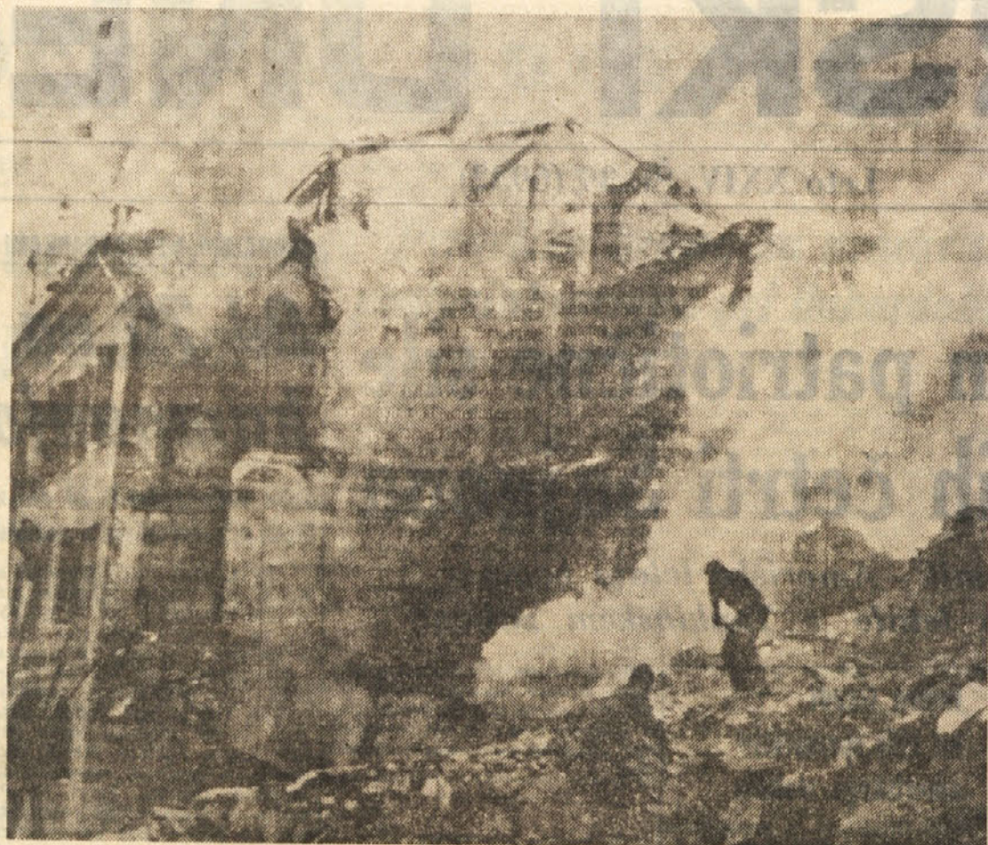
V kraju Castiglione dello Stivere, kakih 40 km od Mantove, je eksplozija gorilni plin v nekem posloju. Eksplozija je pokopala pod ruševinami nekega inženirja in njegovo služkinjo. Moški je umrl, ženska pa je bila ranjena. Policijske oblasti so aretirale delavca, ki je opravil dela pri popravljavi plinovoda
