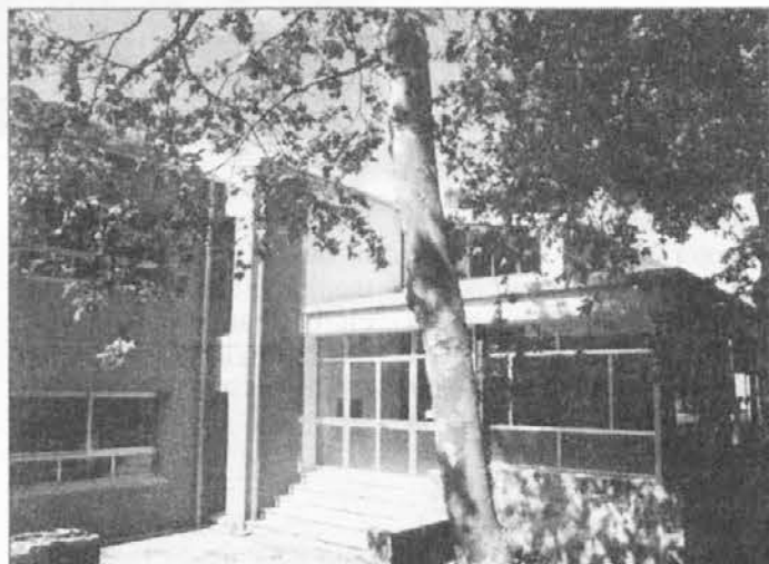
Una veduta dell'entrata dell'edificio che ospita le elementari di Savogna, che con il prossimo anno scolastico potrebbero venire accorpate a S. Pietro al Natisone
