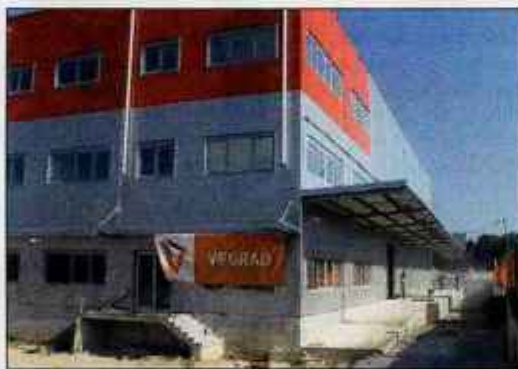
Nov logistično-distribucijski center na Trati je že dobil svojo zunanjo podobo.
