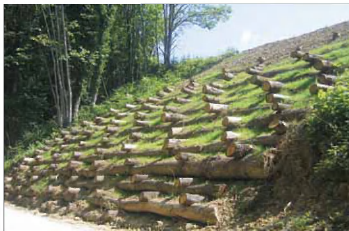
Po lanskih septembrskih nalivih je bila uspešno opravljena sanacija plazu na Opalkovem.
