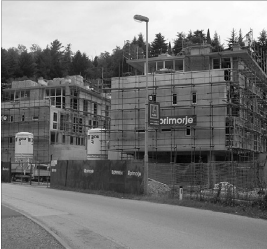
Gradnja neprofitnih stanovanj pod Kapelo poteka po načrtih, vselitev bo marca ali aprila prihodnjega leta
