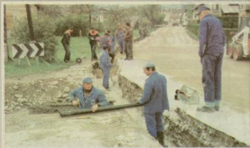
Gradnja plinovodnega omrežja.
