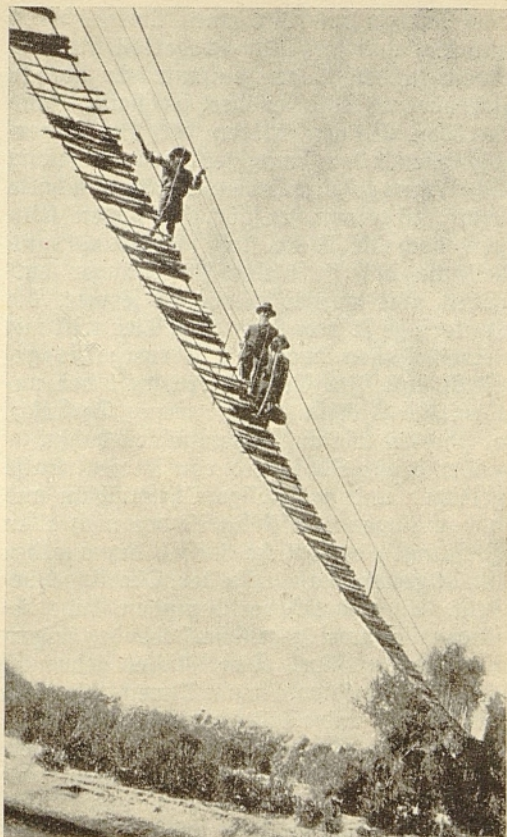
Brücke im Land der Buschmänner. Eine Hängebrücke, die in der Nordwestecke der südafrikanischen Kapkolonie über den Dranjesfluß führt. Der Strom, der an dieser Stelle vier englische Meilen breit ist und mehrere Inseln bildet, wird durch ein sehr leichtes, bei jedem Schritt schwankendes Brückensystem überspannt. Die Missionare, die auf der Brücke zu sehen sind, gehören der Gesellschaft der Oblaten vom heiligen Franz von Sales an.
