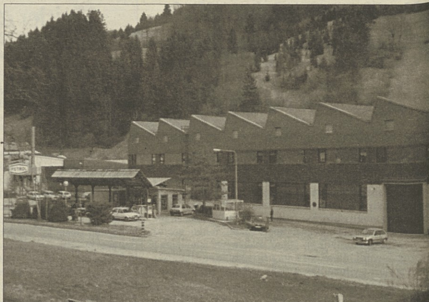
Petrolov servis se umika na novo lokacijo (Foto: Roman Bric)
