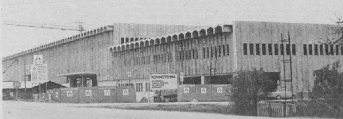
Pogled na skladišča, kjer bo v vseh prostorih 19.122 m 2 površine, iz celjske proti mariborski smeri.
