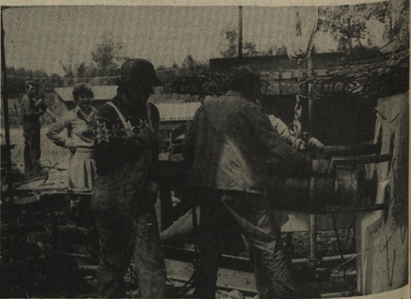
Tudi z dobro opravljenim delom varujemo ugled naše DO (prednapenjanje nosilcev).
