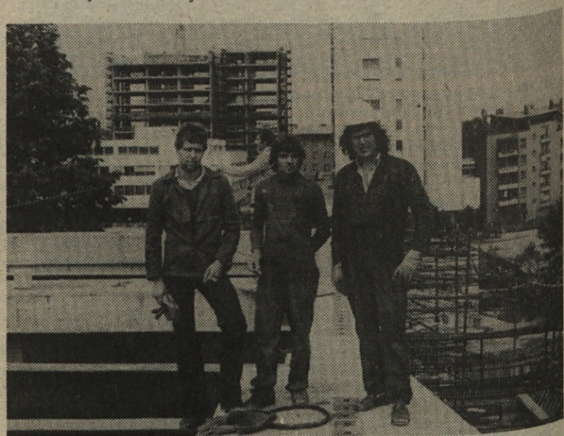
Mladi radnici sa gradilišta Slovenijales
