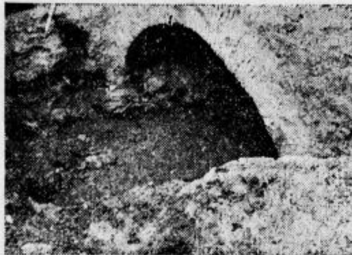
Pogled na močan kletni obok nekdanjega knežjega dvorca na južni strani stavbišča, torej v bližini že stojajočih stavb. Ti oboki in zidovi, na katerih so stoneli oboki, so dali pač največ dela in povzročili tudi precejšnje zakasnitev odkopa.
