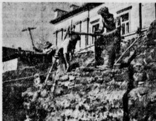
Temeljni zidovi nekdanjega knežjega dvorca. Slika nazorno kaže, kako delavci lomijo kamen za kamnom od zidu, ki je kljub starosti še dokaj trden.
