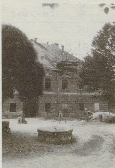
Žovneško graščino, ki je sedež DE Žovnek, Kmetijstvo Žalec, temeljito obnavljajo.
