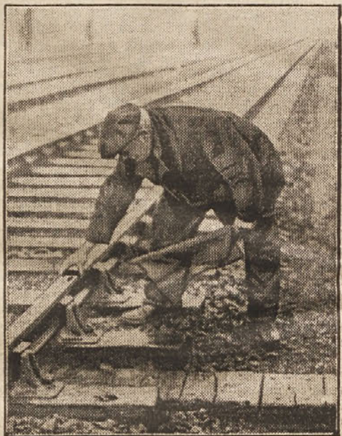
Angleški železniški promet ograja posebno jeseni in spomladi gosta megla. Zaradi tega so postavili na vseh progah okoli 5000 žvaje, ki postavljajo pred signali na tračnico (glej sliko) žvagalnike, ki z detonacijo opozore strojevodjo na signal.
