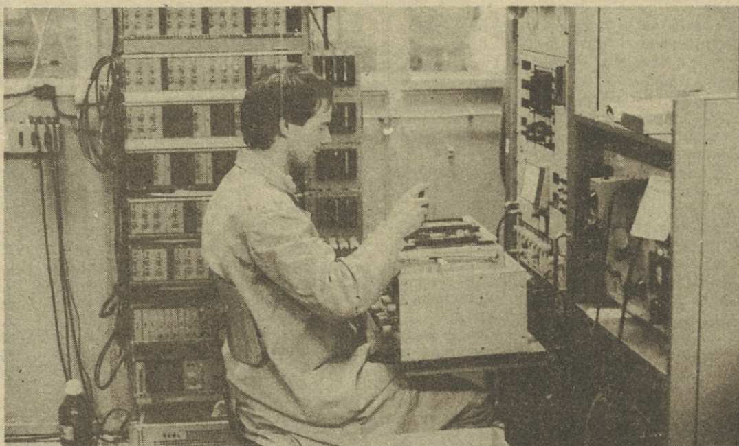
Janez Šilc pri umerjanju kanalskih modulatorjev
