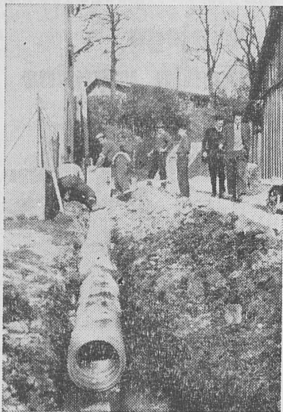
Polaganje vodovodnih cevi na Rakeku
