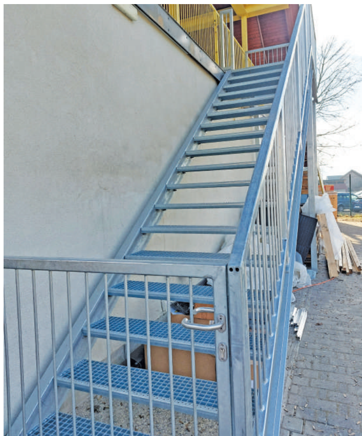
Foto 2: Zamenjava požarnih stopnic na objektu Vrtca Medo na Prevojah pri Šentvidu
