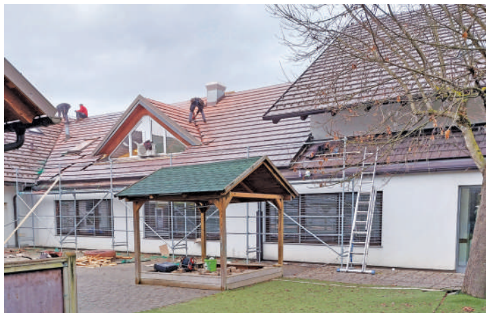
Foto 3: Sanacija strehe na objektu Vrtca Medo na Prevojah pri Šentvidu
