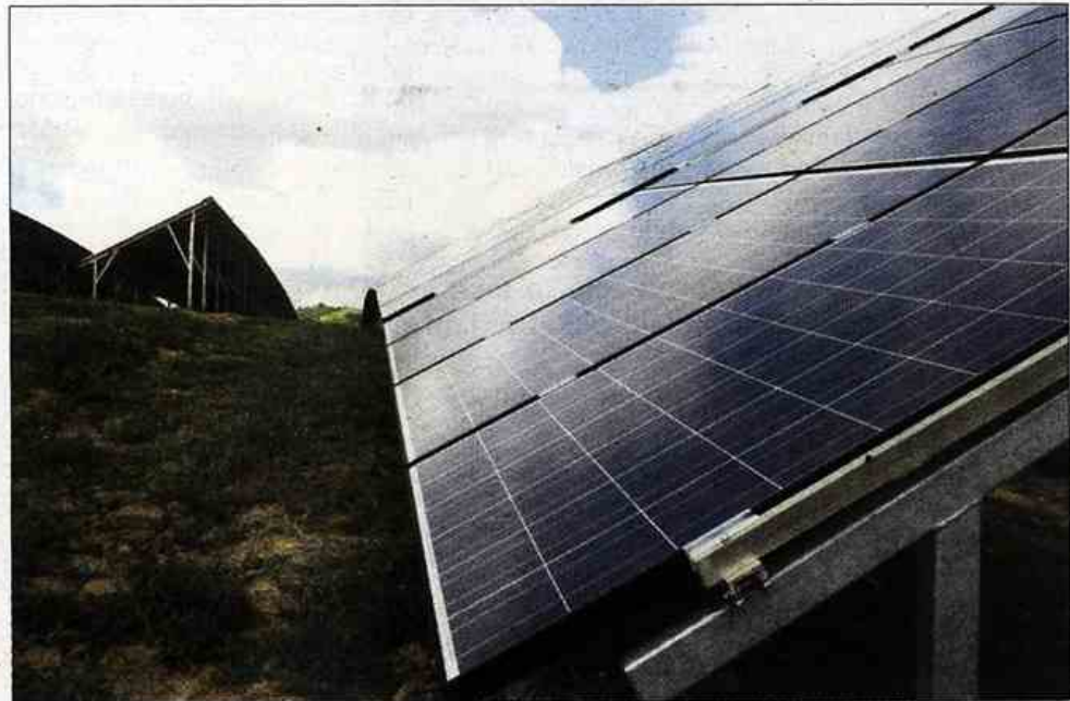
Proizvajalcev sončnih celic je veliko, zakonca Dobravc sta se odločila za Bisolove. Železno konstrukcijo sta naredila sama.
