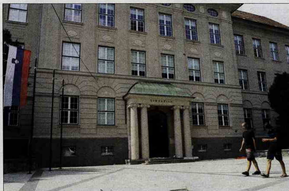
Mogočen objekt I. gimnazije v Celju je dobil čisto svežo podobo.
