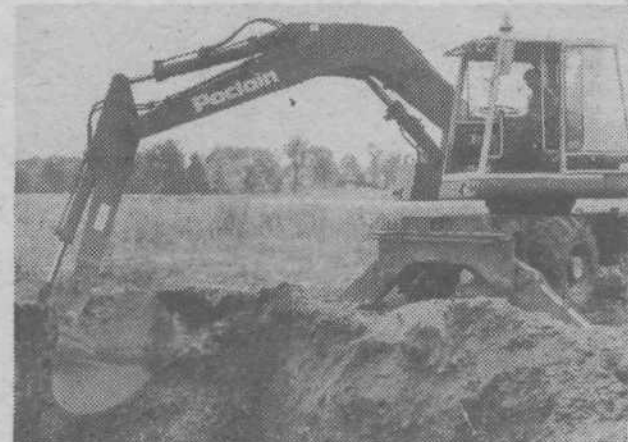
Fužine — začetek septembra '79: Globlje — za trdnješe temelje (Foto: DARJA)
