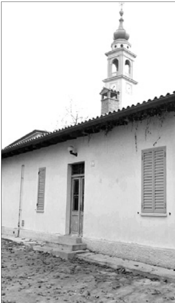
Objekt v neposredni bližini šolske stavbe je danes neke vrste skladišče, dotrajan je in neizkoriščen
