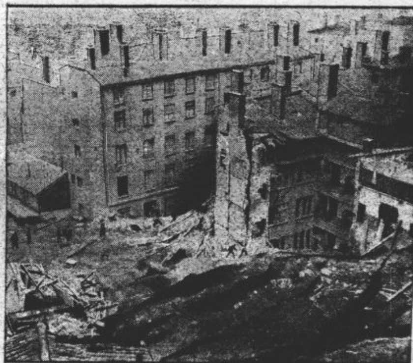
Razdejanje v mestnem delu St. Jeanu, kamor so se vsuli plazovi z griča Fourvière. V ospredju zasute in porušene hiše, zadaj poslopja, ki so ostala deloma nepoškodovana.
