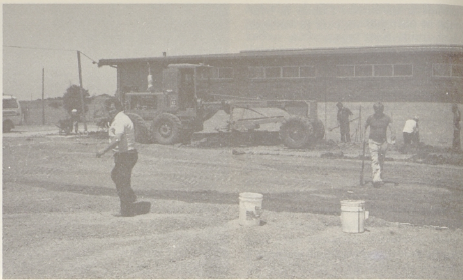
Priprava za temelje
