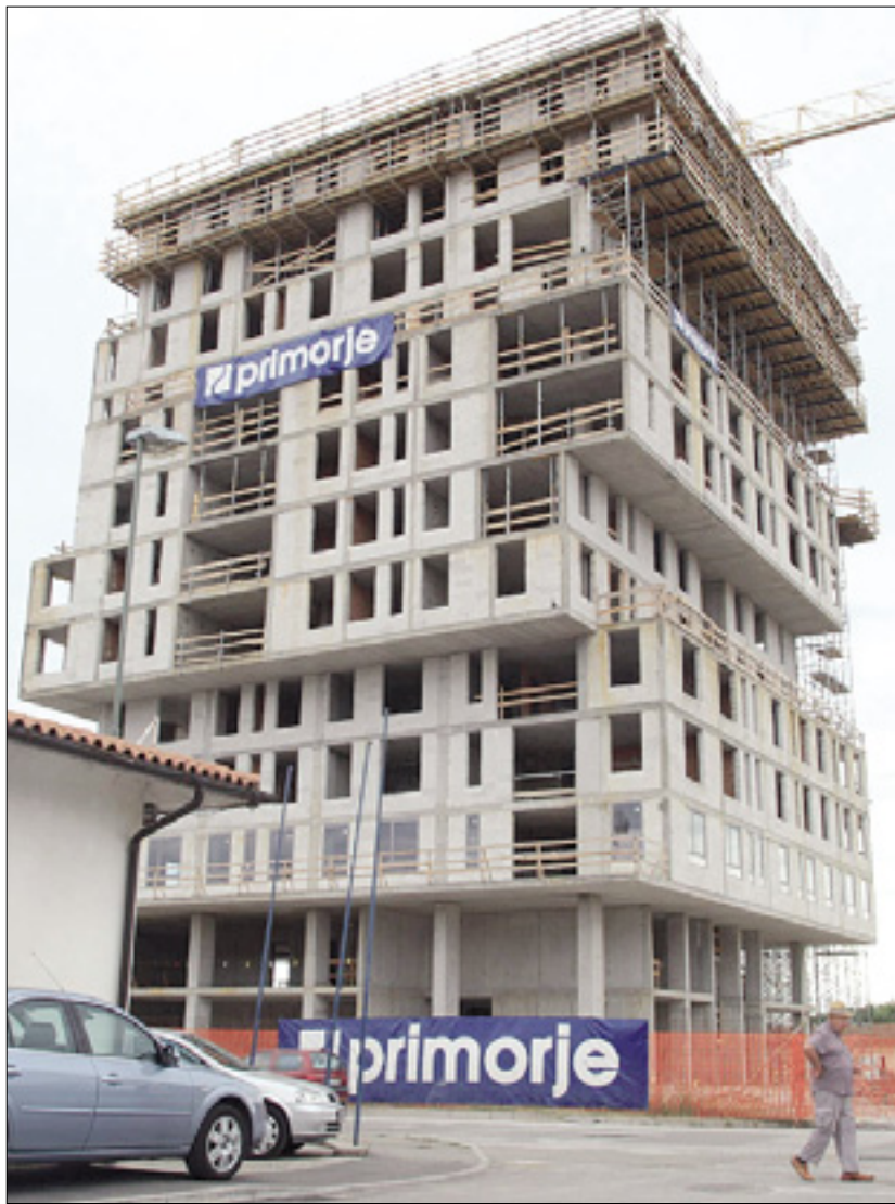
Prva stolpnica z enajstimi nadstropji meri v višino 38 metrov
