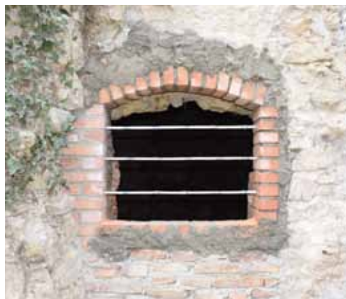
Za nemoten prelet veliki podkovnjaki ( Rhinolophus ferrumequinum ) potrebujejo odprtino, široko vsaj petdeset centimetrov in visoko vsaj dvajset centimetrov. Kletna okna pred obnovo in po njej. Foto: Jasmina Kotnik.
