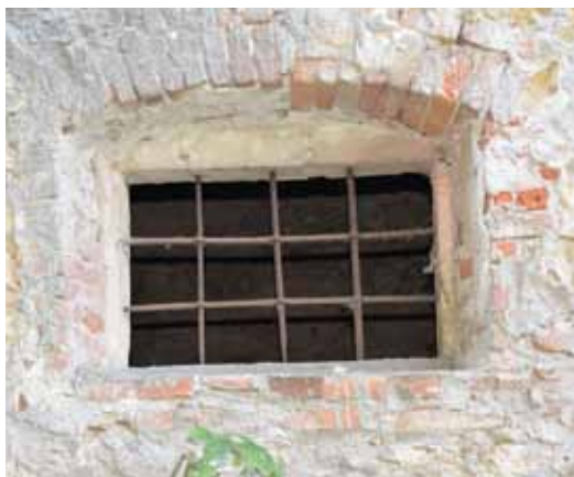
Za nemoten prelet veliki podkovnjaki ( Rhinolophus ferrumequinum ) potrebujejo odprtino, široko vsaj petdeset centimetrov in visoko vsaj dvajset centimetrov. Kletna okna pred obnovo in po njej. Foto: Jasmina Kotnik.
